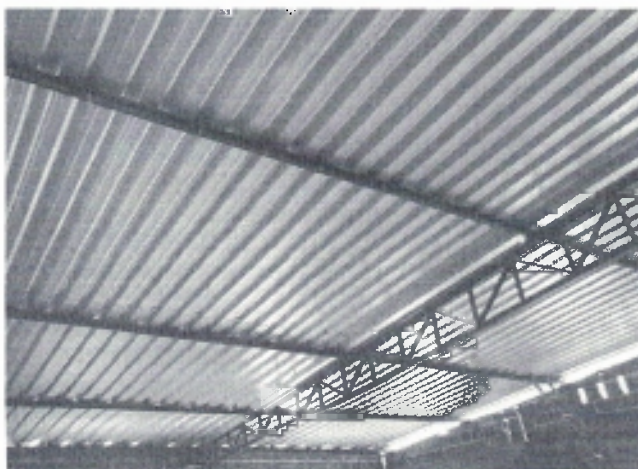
Figura 1 - Cobertura em telha aluzinco
