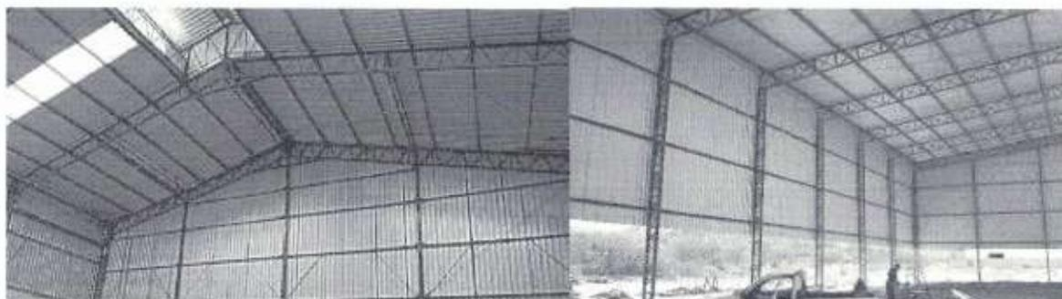
Figura 1 - Estrutura de fechamento telha aluzinco
